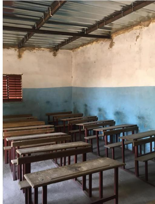
Les travaux du toit ont été réalisés avec sérieux et les termites ne pourront plus manger les poutres....elles sont en fer maintenant
