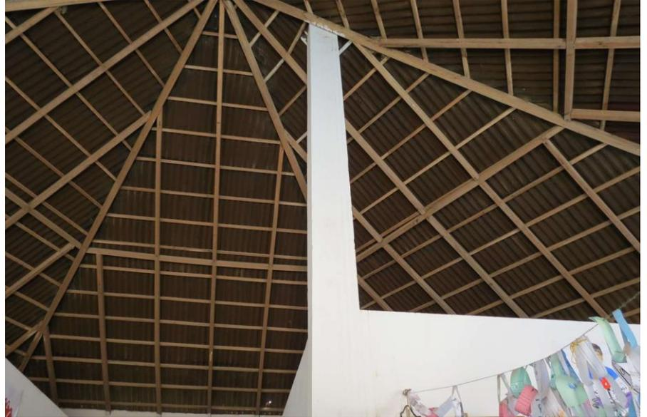
Compte tenu de la hauteur du plafond, la chaleur s'accumule dans la salle principale, aussi, nous envisageons de faire faire un faux plafond à 2m40 afin d'isoler un peu. Nous prévoyons également une ventilation murale et plafond pour le confort de ces bouts de choux. Les devis sont en-cours....
